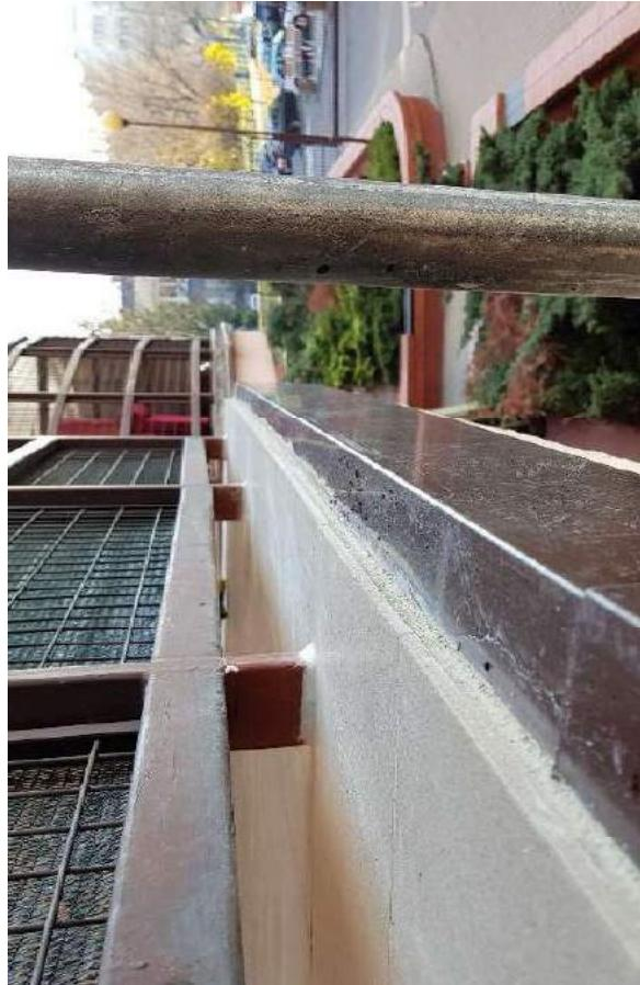
Zdj. 20. Obróbkę z blachy stalowej, malowanej.
