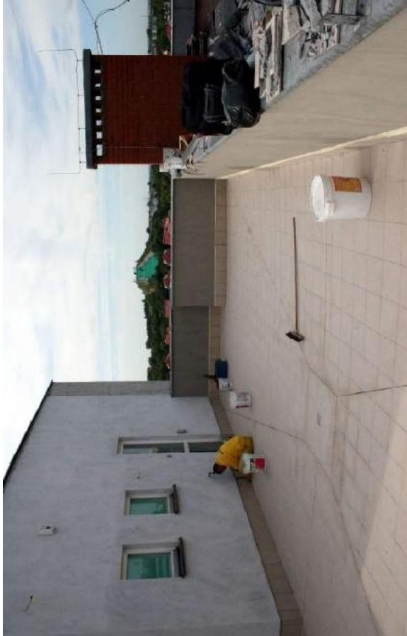
Zdję. 24. Zdjęcie powyżej przedstawia obróbkę stalową z zabezpieczeniem wierzchniej warstwy za pomocą żywicy epoksydowej z posypką kwarcową. Takie rozwiązanie ochroni parę powierzchnie blachy oraz zwiększa przyzeganność kolejnych warstw.
