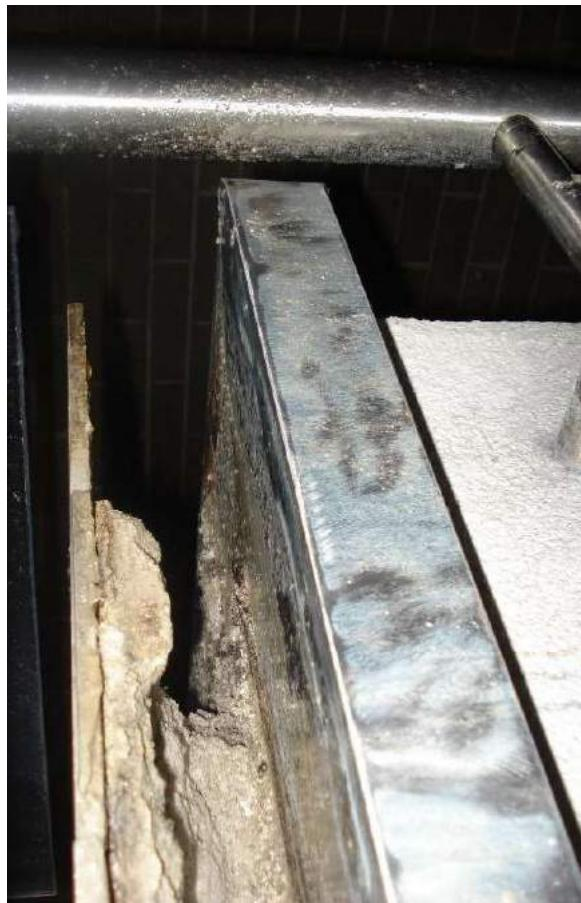
Zdj. 18. Skutki nieprawidłowo zamocowanej obróbki bławarskiej bez spadku.
