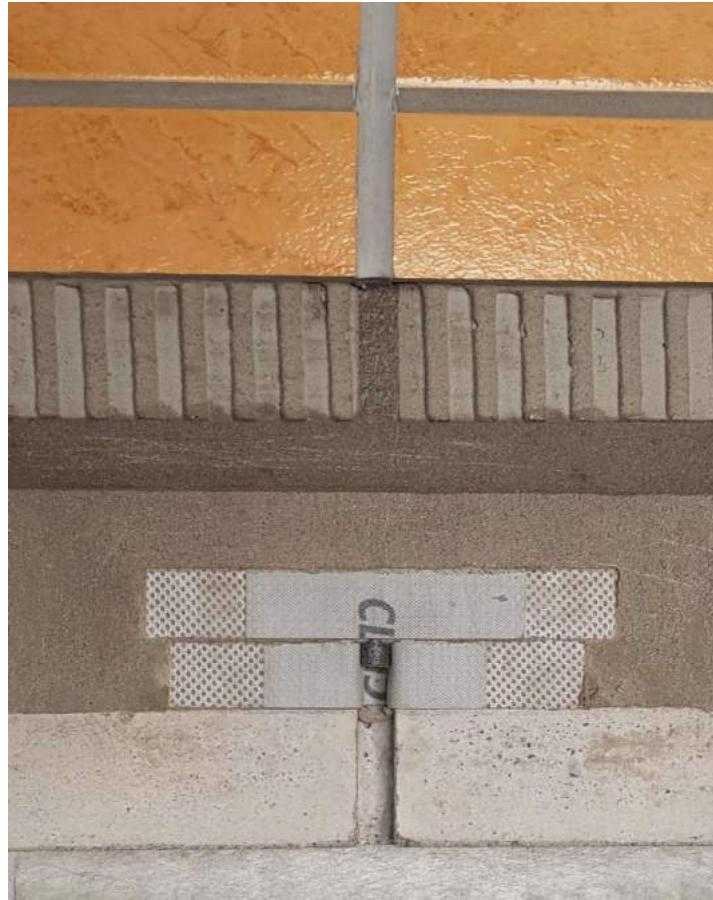
Zdj. 15. Zabezpieczenie dylatacji za pomocą taśmy uszczelniającej i sznura dylatacyjnego.
