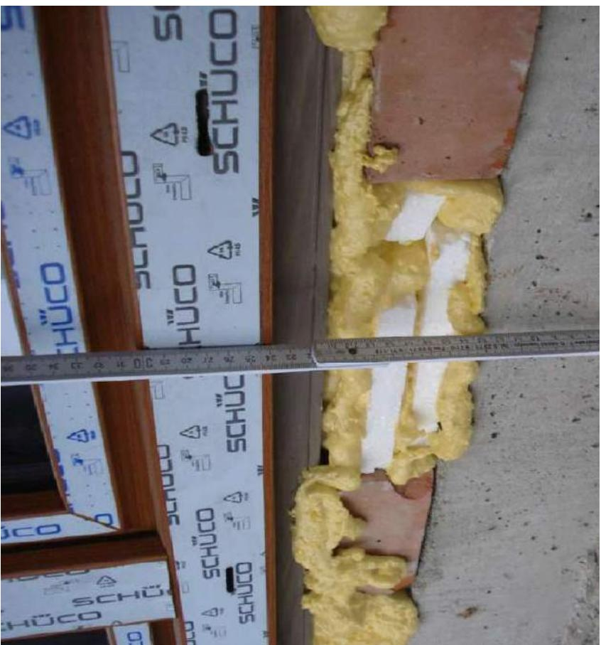
Zdj. 14. Brak prawidłowo wykonanej podbudowy drzwi balkonowych.
